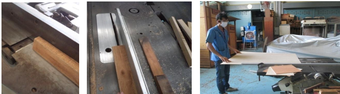
ตัดโครงไม้และแผ่นปิดผิว
